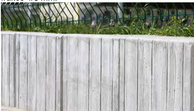
Obr. 10 Ukázka opěrné zdi úhlové (převzato z: www.csbeton.cz)
